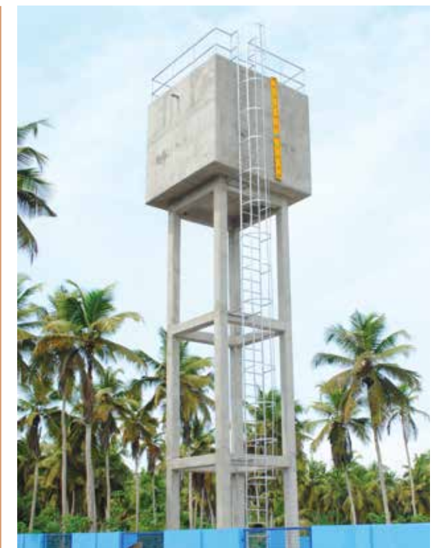
Installation de traitement, de pompage et de stockage d'eau construite par Kosmos Energy.
